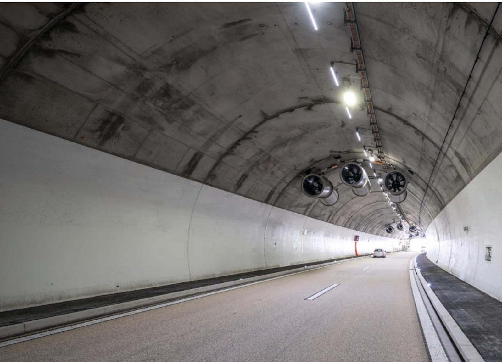
Mit helleren Belägen wie in der Entlastungsröhre des Belchentunnels (BL/SO) kann der Energieverbrauch für die Tunnelbeleuchtung gesenkt werden.
