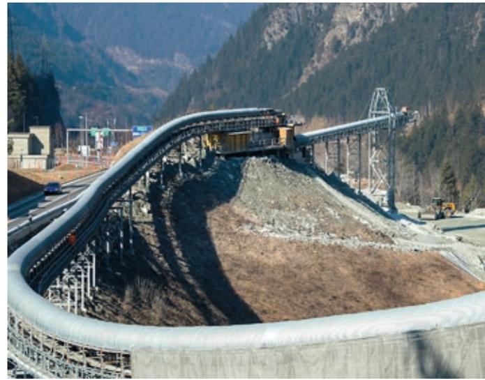
Beim Nordportal in Göschenen: Das Förderband für das Ausbruchmaterial beim Bau der zweiten Gotthard-Strassenröhre.
