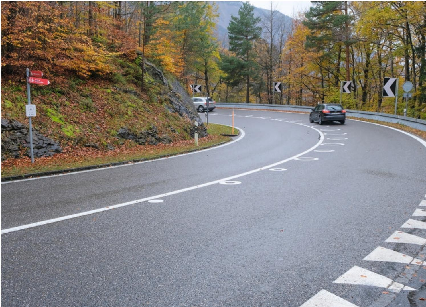
Die Sondermarkierung mit Kreisen als Fahrhilfe auf der Strecke des Brünigpasses.
